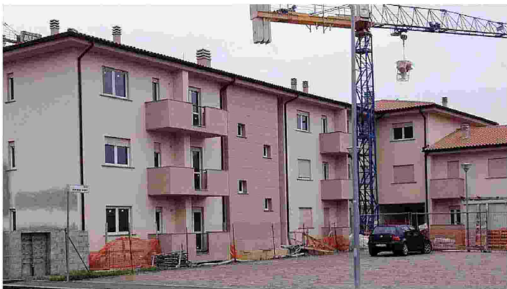
Alcuni degli immobili in via di costruzione
