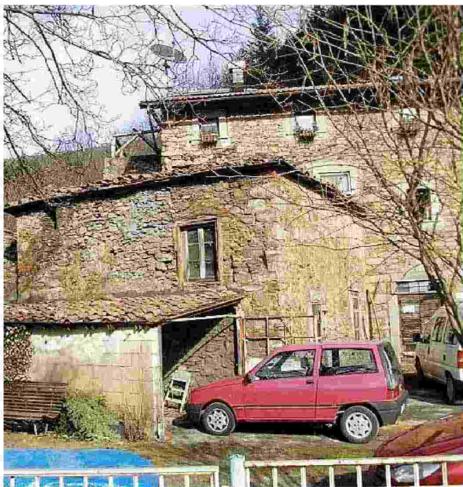
Una veduta dell'edificio in ristrutturazione della vecchia ferriera
